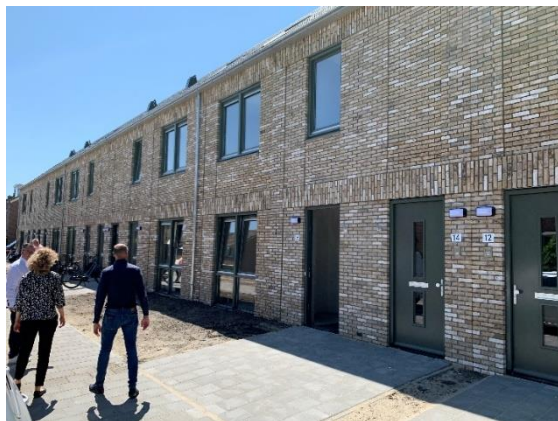
Foto 1 Opgeleverde woningen aan de Frans Halsstraat
