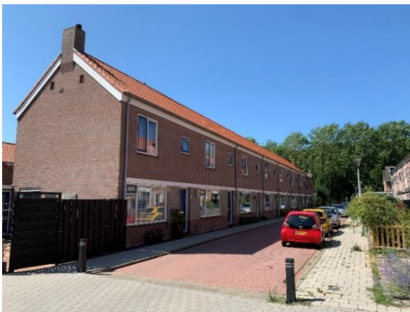
Foto 2 Recent gerenoveerde woningen
